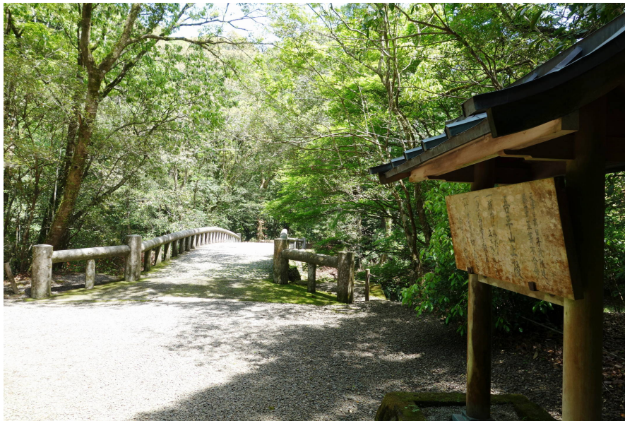
コンクリート橋
